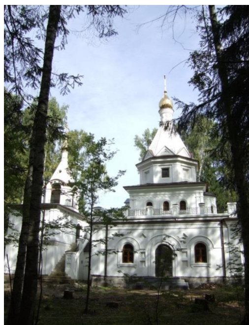
Рис 11. Церковь «Всея святых», построенная с применением наноцемента 90 в тонкостенных (40 мм) куполах сооружения в г.Дубна, 2005 г.
