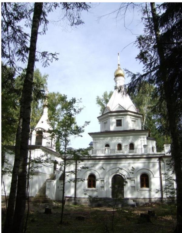
Рис 2. Церковь «Всея святых» ,построенная с применением наноцемента 90 в тонкостенных ( 40 мм) куполах сооружения в г.Дубна ,2005 г.
